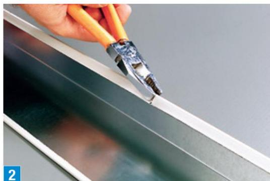
2 Aplatir le larmier au niveau de la ligne de coupe afin de faciliter la pliure parfaite à l'endroit souhaité.
