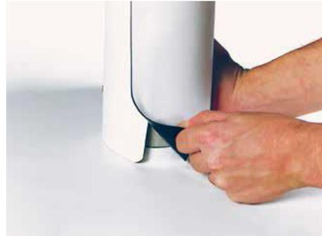
La hauteur de la bande doit être identique à la hauteur du corps cylindrique, avec un excédent de 3 cm pour la soudure sur la partie courante. Réaliser le pontage, la pré-soudure et la soudure de la ligne de superposition verticale.
