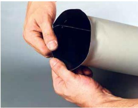
Ôter le cylindre ainsi obtenu et étirer manuellement l'excédent pour la soudure sur la partie courante.
