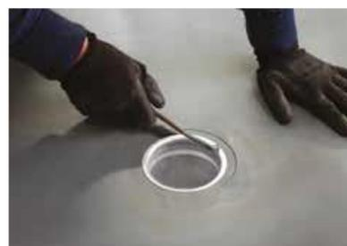
Dans le cas de l'emploi de la DRAINI PVC avec la membrane feutrée en sous face FLAGON SRF, celle-ci sera soudée sur la membrane
