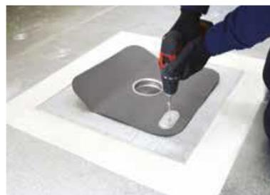
La membrane de partie courante est soudée sur l'intégralité de la platine de la naissance DRAINI EP PVC. Le contrôle de la soudure est effectuée de façon habituelle à la pointe sèche
