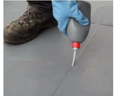
**Nota :** Bien que non obligatoire pour les soudures à air chaud, cette finition est conseillée en tant que témoin d'exécution de l'autocontrôle de chantier. Elle est cependant nécessaire pour cacher la tranche grise de la couche inférieure des membranes colorées.
